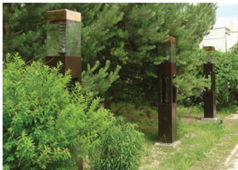
Коттеджный поселок. Московская область. Светильники КВАДРО.
